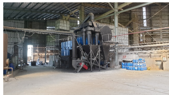
Lò hơi cấp nhiệt cho MSVN
