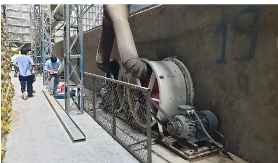
Quạt HT- 1T 1100 lắp tại DN 4
