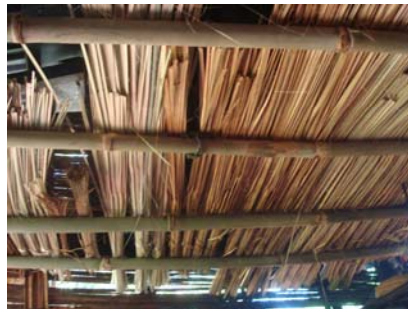
Hình 8: Lạt làm dây buộc
