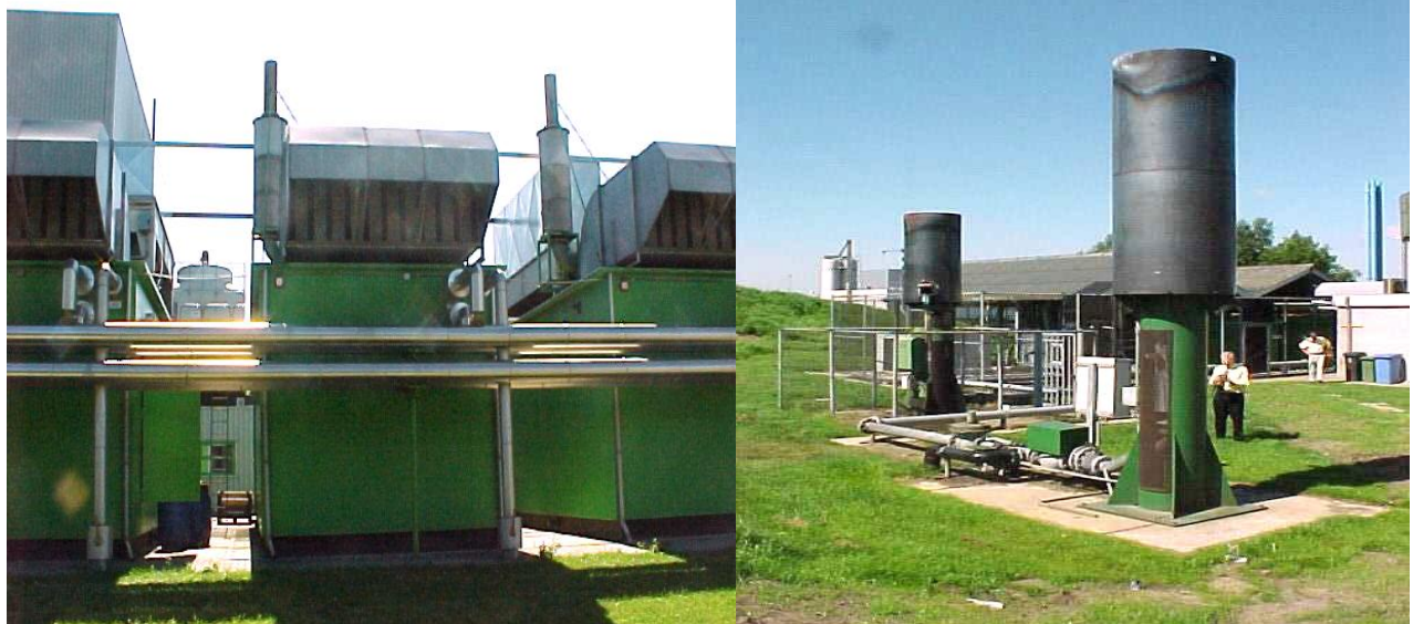
Hình4. về hệ thống lọc khí, tuốc bin, máy phát điện và đầu đốt khí
