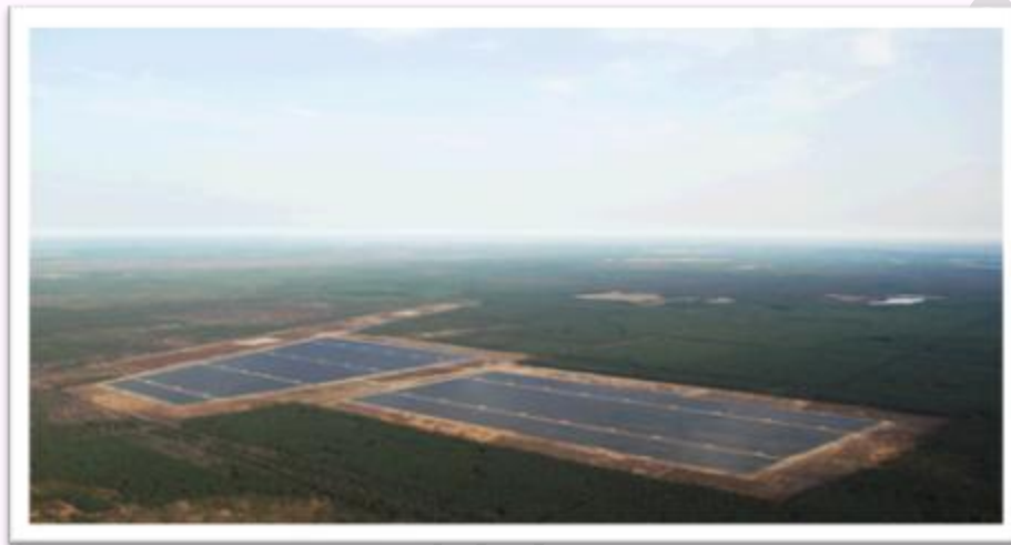
Hình: Công viên quang điện Lieberose 71,8 MW tại Đức.
