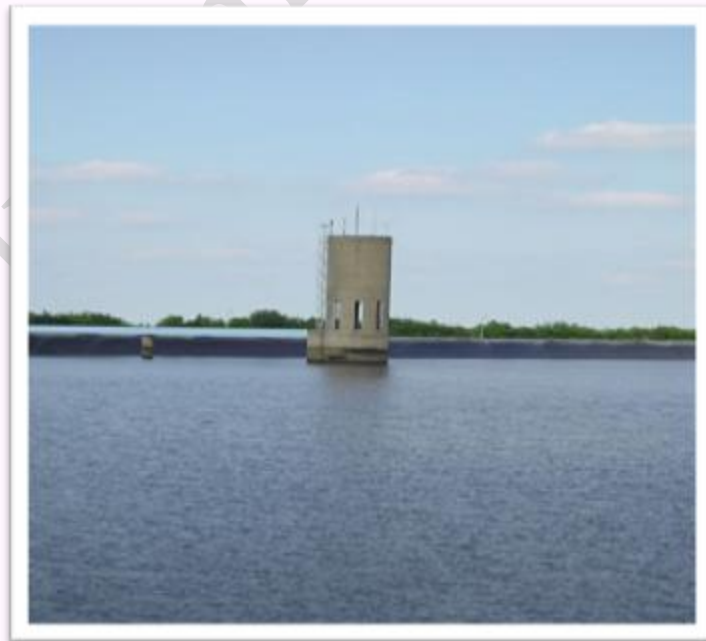
Hình: Hồ chứa nước thủy điện Vianden, Luxembourg (tháp).
