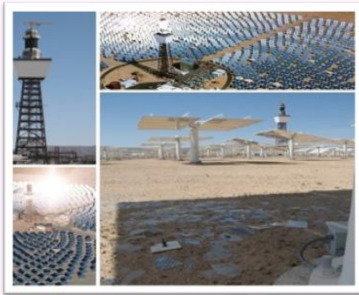
Hình: Hệ thống lưu trữ nhiệt của Solar Two tạo ra điện trong thời tiết nhiều mây và vào ban đêm.
