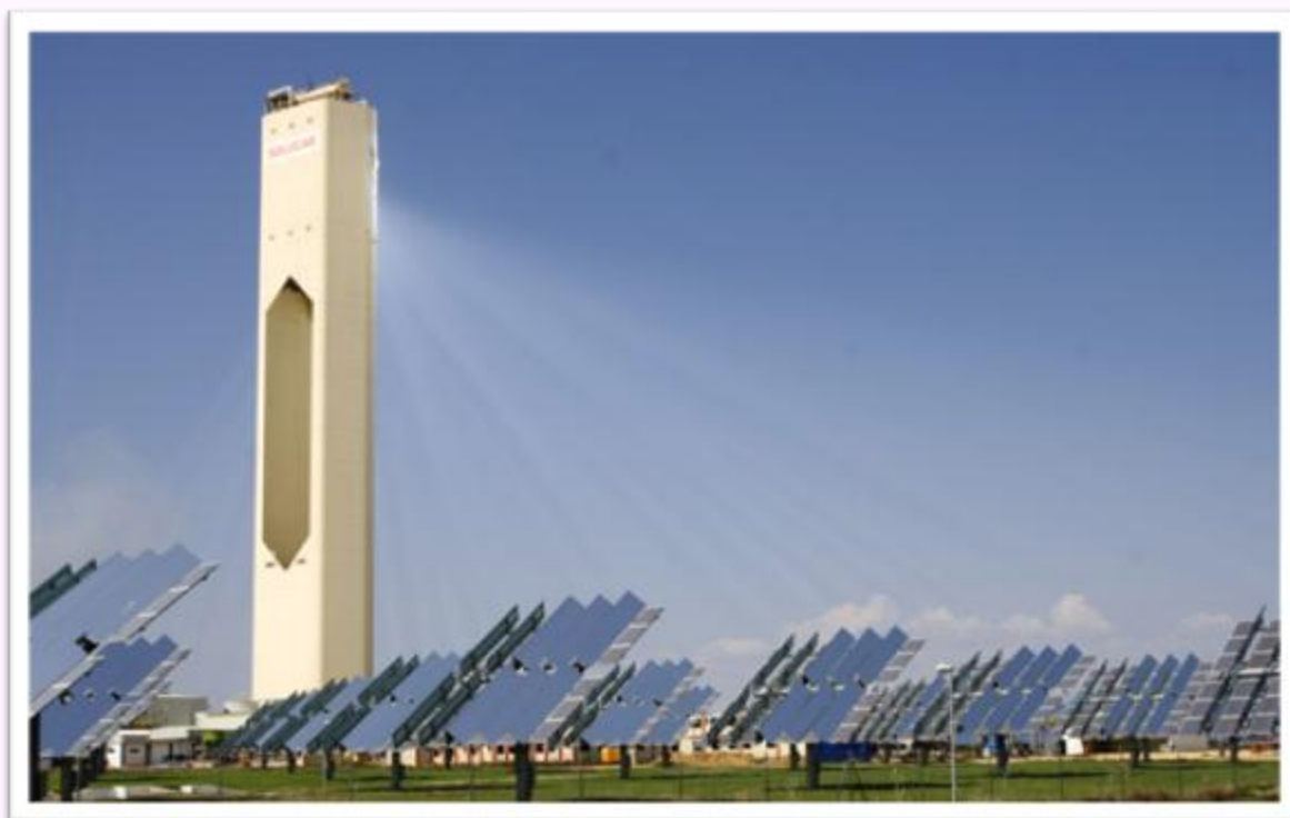
Hình: Các PS10 tập trung ánh sáng mặt trời từ cánh đồng heliostats trên một tháp trung tâm.
