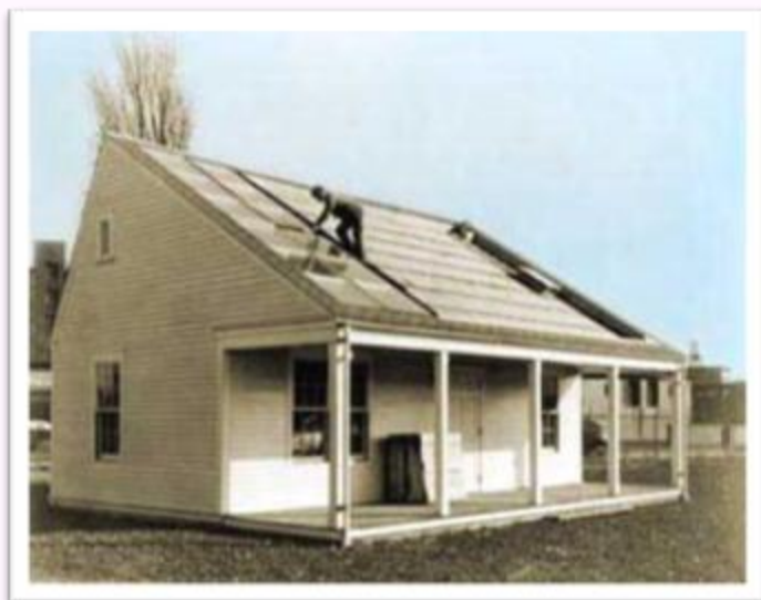
Hình: Ngôi nhà mặt trời # 1 của Viện công nghệ Massachusetts tại Hoa Kỳ, được xây dựng vào năm 1939, sử dụng lưu trữ nhiệt theo mùa để sưởi ấm quanh năm.
