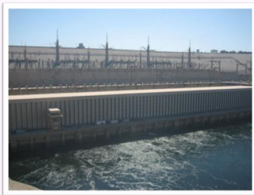
Hình: Nhà máy phát điện đập Aswan, Ấn Độ.
