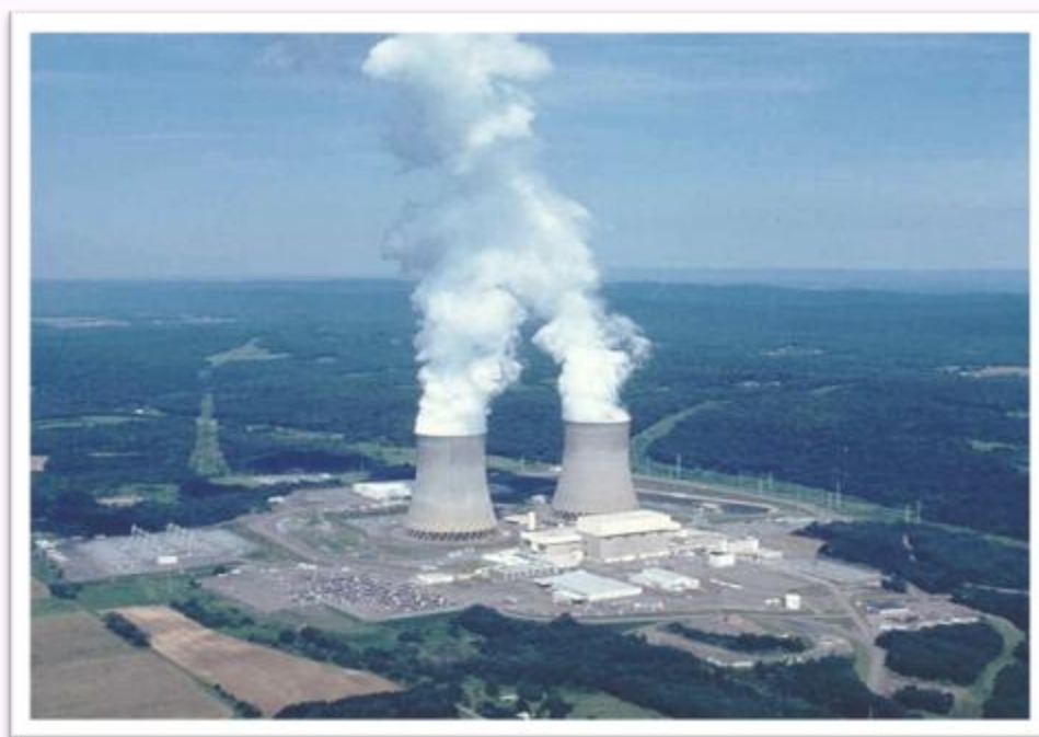
Hình: Trạm phát điện hơi nước Susquehanna, lò phản ứng hơi nước. Các lò phản ứng được đặt trong các tòa nhà bảo vệ hình chữ nhật phía trước các tháp làm lạnh.
